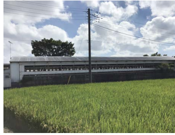
(写真2) ストール舎
