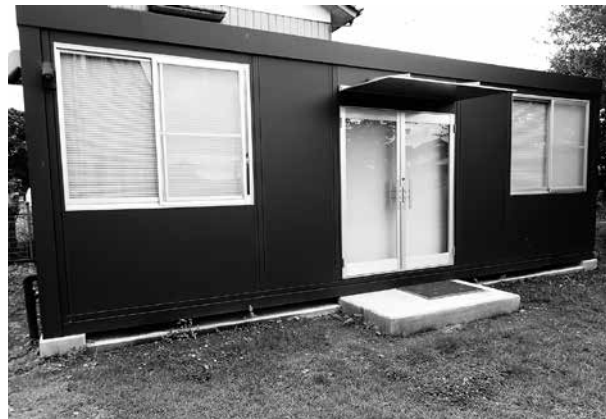
ユニットハウス外観
