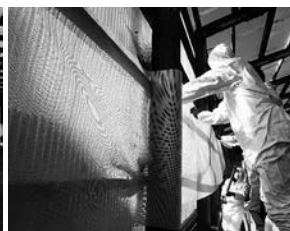
シート取り付け作業の様子
