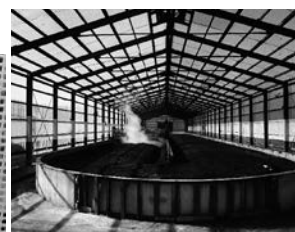
シート取付後 (令和2年12月設置)
